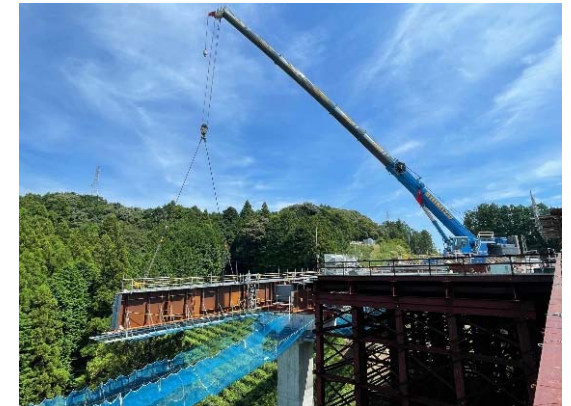
「真夏日の架設」 国道473号バイパス（島田市神谷城）
