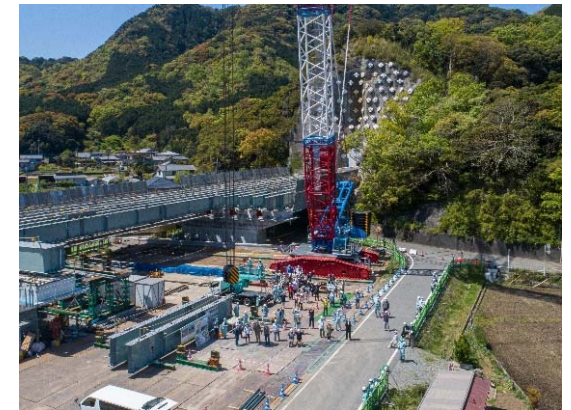
「クレーンと橋と地元の方々」 国道414号 静浦バイパス（沼津市大平）
